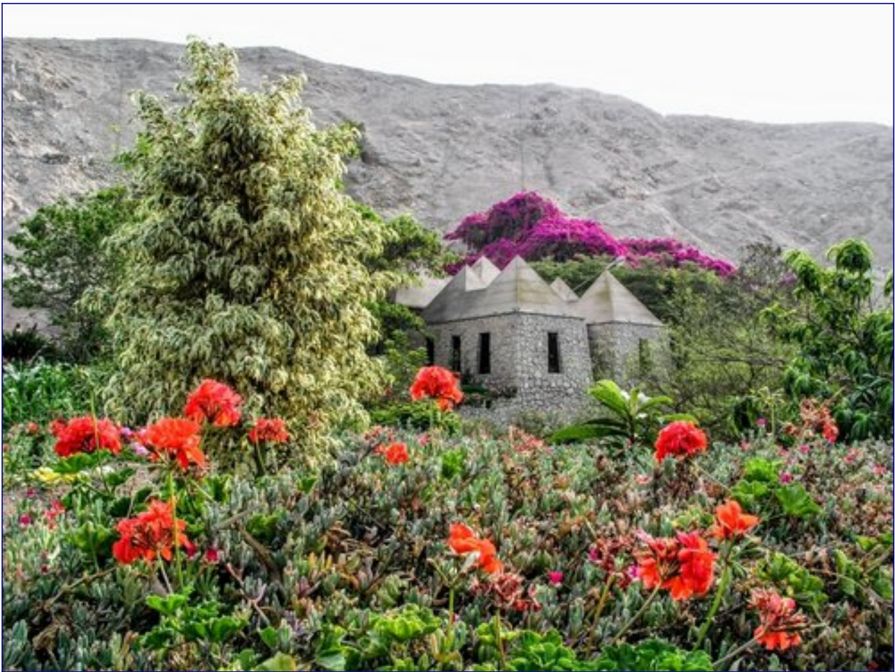
Complexul din zidărie piatră naturală și structură piramidală de acoperiș
